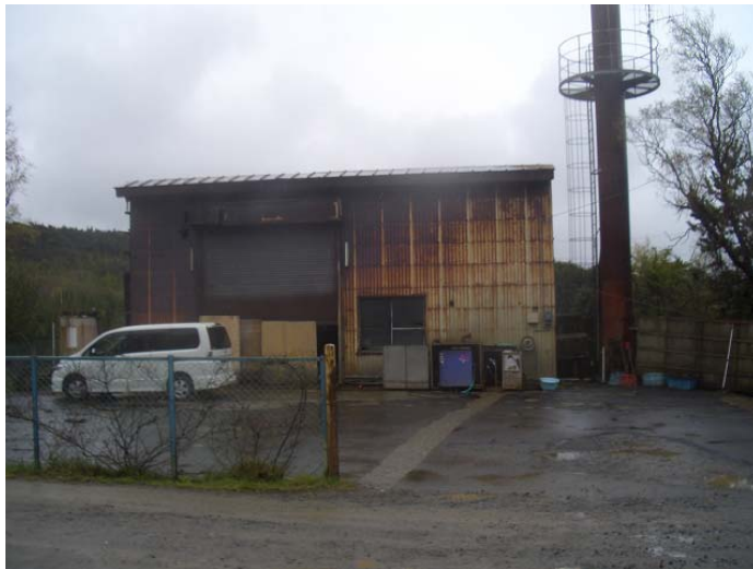
【廃止済ごみ焼却施設(大間町)】
