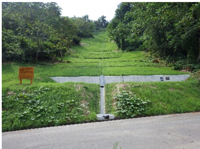
平成27年度県営予防治山工事(平川市) 完成検査:平成28年9月27日
