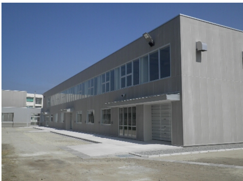
五所川原工業高等学校機械科実習棟改築工事(五所川原市) 完成検査:平成28年6月3日
