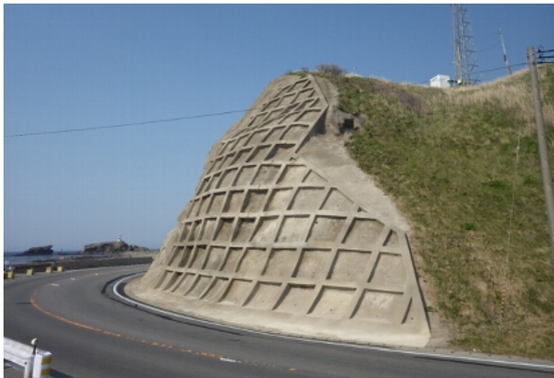
国道101号道路災害防除工事(中泊町) 完成検査:平成28年6月10日
