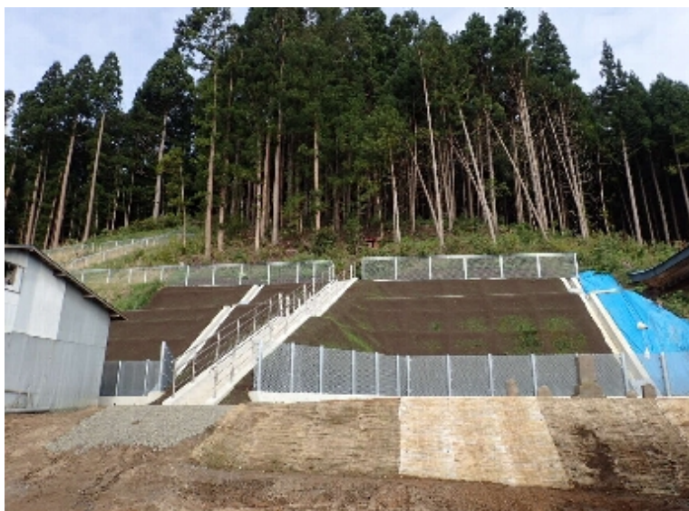
大沢田1号区域急傾斜地対策工事(十和田市) 完成検査:平成28年9月9日
