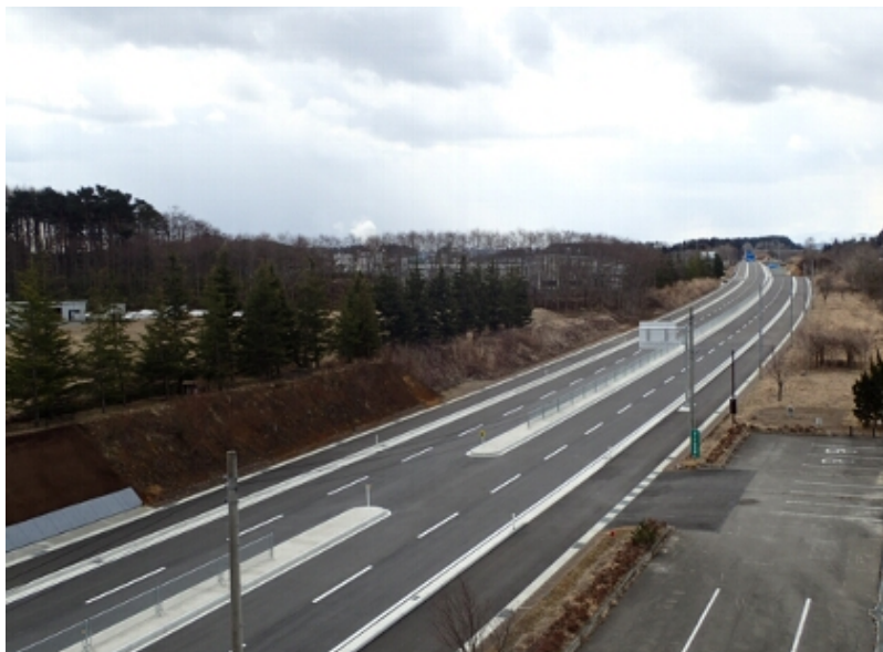
八戸環状線舗装新設工事(八戸市) 完成検査:平成29年3月23日
