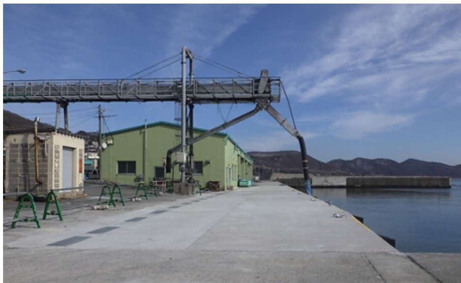
写真-12 小泊地区水産流通基盤整備工事(中泊町) 完成検査:平成29年3月24日
