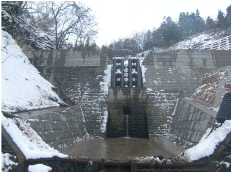
築出沢通常砂防工事(鱒ヶ沢町) 完成検査:平成28年12月14日
