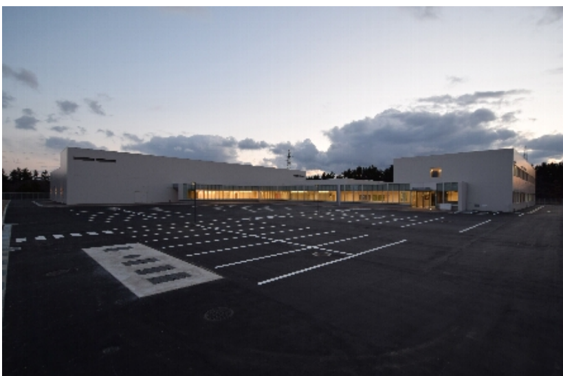
青森県原子力人材育成・研究開発拠点施設(仮称)新築工事(六ヶ所村) 完成検査:平成29年3月31日
