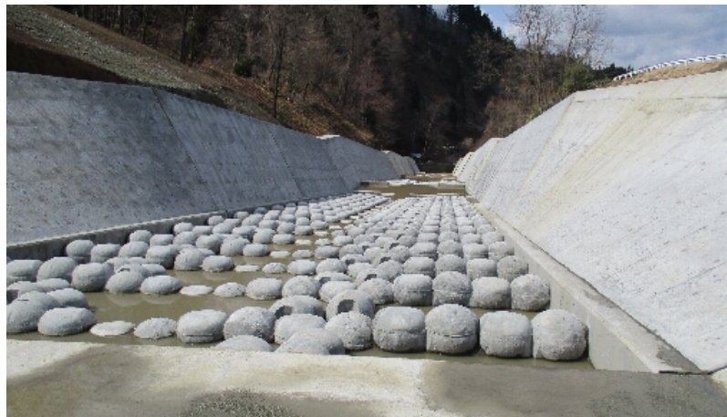
津刈1期応対第12号工事(平川市) 完成検査:平成29年3月31日
