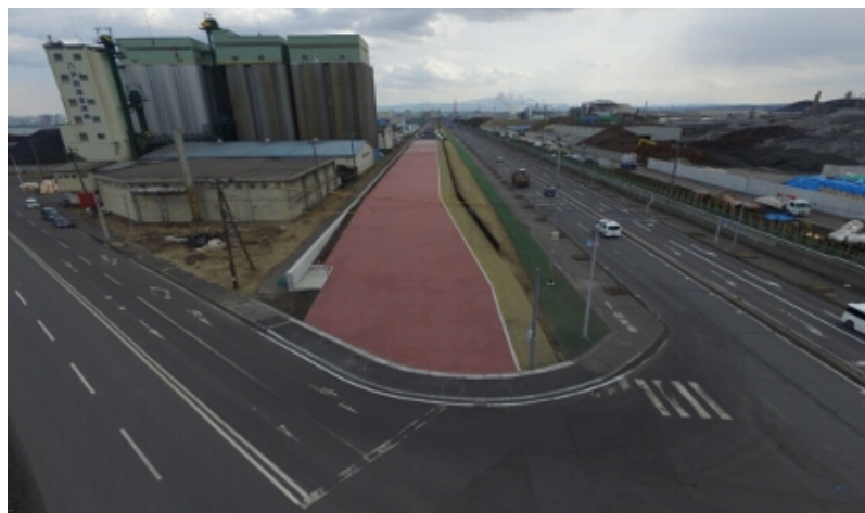
八戸港海岸環境対策八太郎緑地嵩上工事(八戸市) 完成検査:平成29年3月31日
