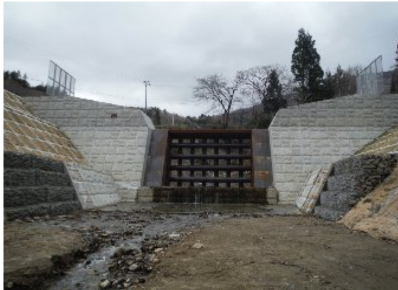
小川平沢通常砂防工事(青森市) 完成検査:平成29年3月29日
