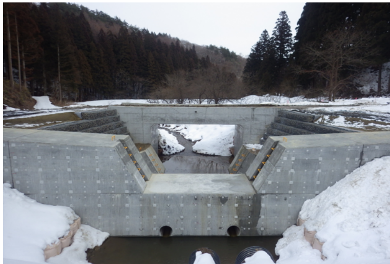
茂市沢火山砂防工事(田子町) 完成検査:平成29年3月22日
