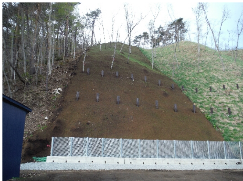
雷電林1号区域急傾斜地崩壊対策工事(平内町) 完成検査:平成29年3月10日
