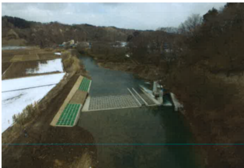
留崎河川対応第3号工事・留崎魚道第2号工事(三戸町) 完成検査:平成29年3月30日
