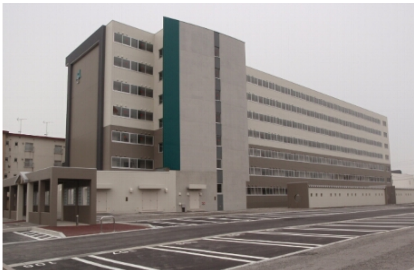
県営住宅小柳団地2号棟建設工事(青森市) 完成検査:平成29年3月27日
