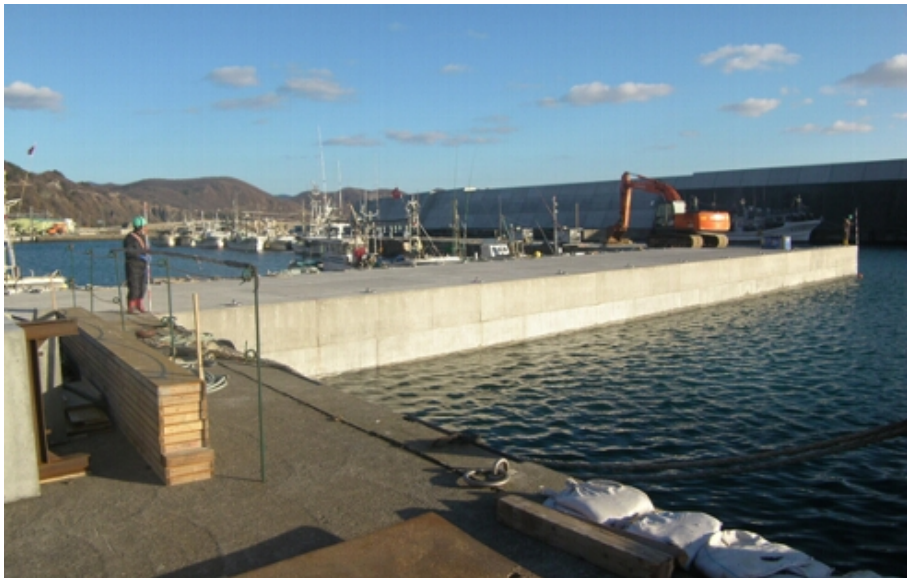
西北地区(小泊漁港)水産物供給基盤機能保全工事(中泊町) 完成検査:平成29年1月6日
