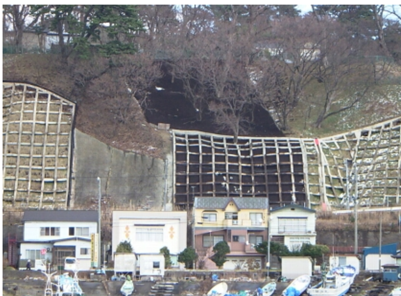
万年坂区域急傾斜地崩壊対策工事(深浦町) 完成検査:平成29年1月18日
