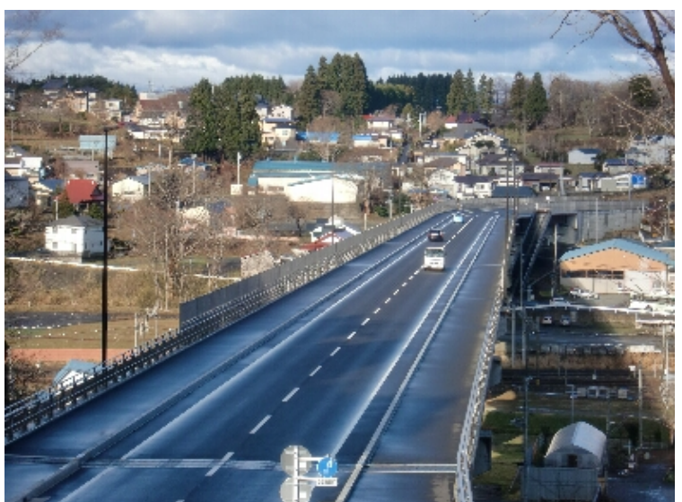
中央町金矢線道路改良三沢大橋舗装工事(三沢市) 完成検査:平成28年4月27日
