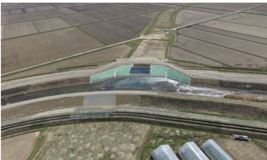
神原中里線橋梁整備工事(中泊町) 完成検査:平成28年4月28日
