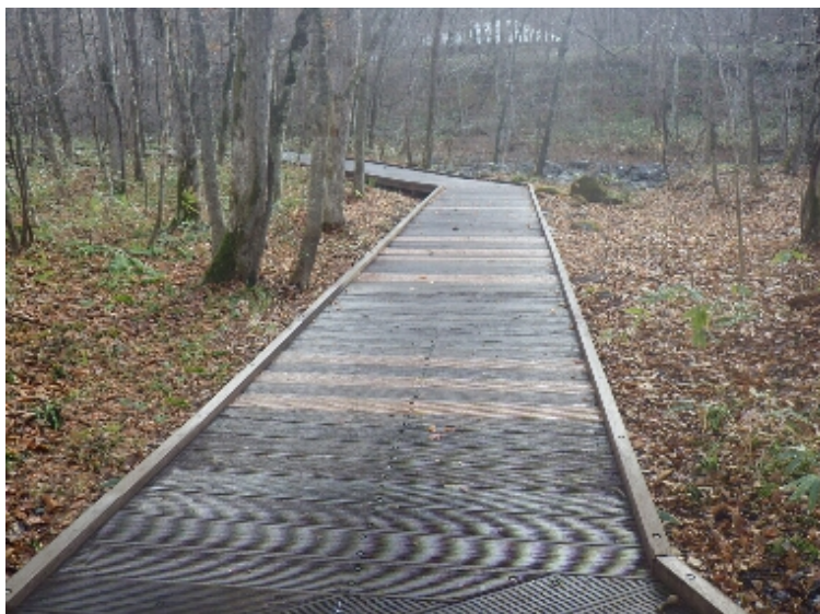
鳶川砂防整備工事(十和田市) 完成検査 : 平成28年12月12日
