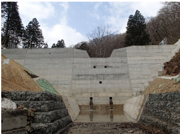
押付沢砂防総合流域防災工事(六ヶ所村) 完成検査:平成29年3月24日
