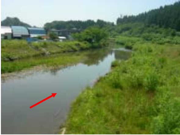
現況写真(改修済み区間)
