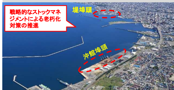
係留施設の老朽化対策の実施 【青森港】
