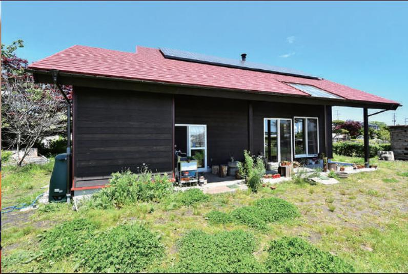
県産材を使用した部分 (内装) アカマツ(床) スギ(内壁・勾配天井) (構造) ケヤキ(大黒柱)・カラマツ(大引き・根太) クリ(土台)・スギ(柱・母屋束・桁・母屋)・アカマツ(梁) (外装) スギ(外壁)
