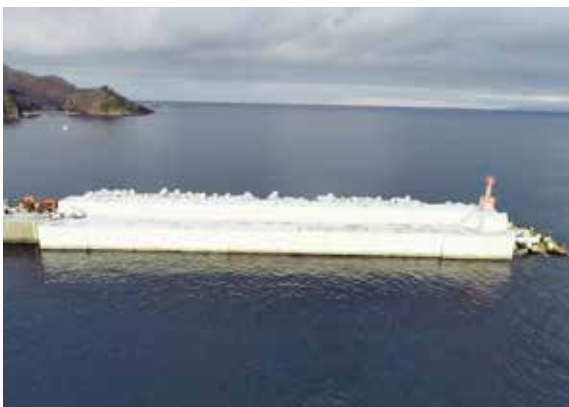
越波防止のための既存防波堤の嵩上げ改良 (小泊漁港)
