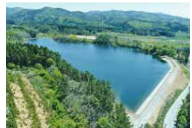
耐震化されたため池（横浜町）
