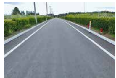
走行性が向上した農道（五戸町）
