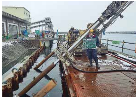
グラウンドアンカー工法による陸揚げ岸壁の耐震化 (三沢漁港)
