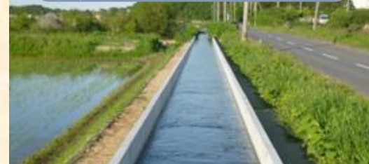
農業水利施設の更新
