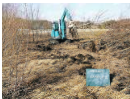
写真1 抜根作業
