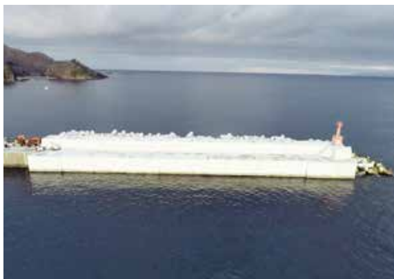
既存防波堤の嵩上げによる越波防止対策 (小泊漁港)
