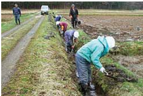
水路の泥上げ
