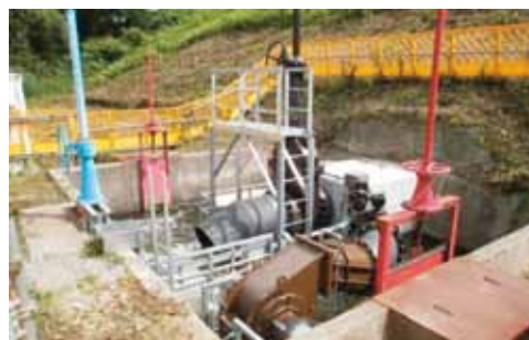
長橋溜池発電施設 (五所川原市)
