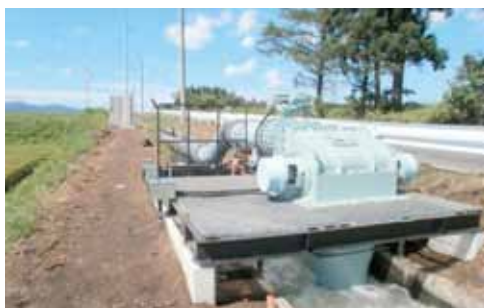
早川1号発電施設 (七戸町)
