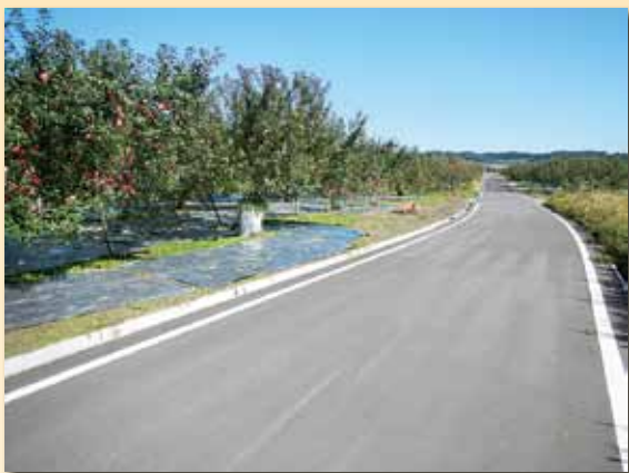
樹園地農道の整備 野沢2期地区（青森市）
