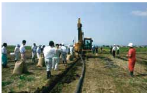
施工見学会 (十三湖地区)
