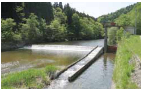
大畑頭首工（改修前）
