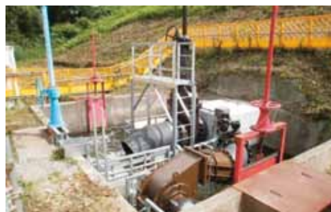
長橋溜池発電施設 (五所川原市)
