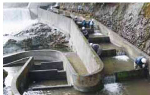
協議会による薬研魚道の補修
