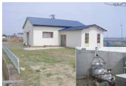
ポンプ場の改修による排水条件の向上
