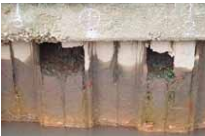
水路の老朽化
