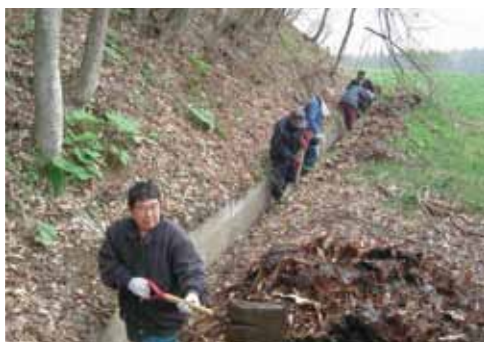
水路の泥上げ
