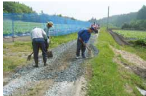
道路の砂利補修
