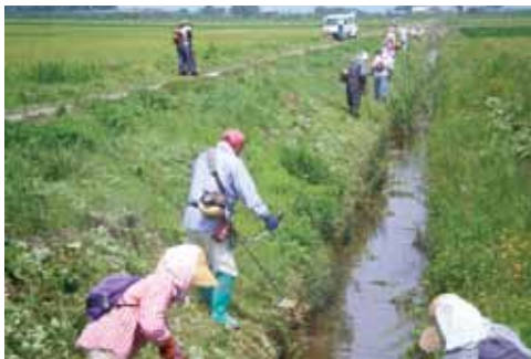
排水路の草刈り
