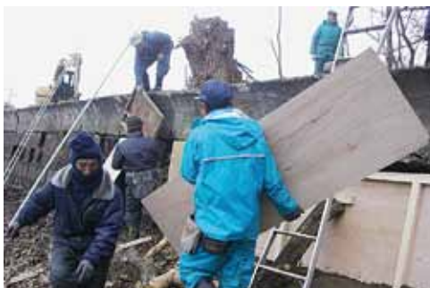
ため池の堤体補修
