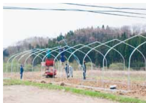
ハウスの設置状況
