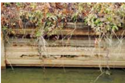
水路の老朽化
