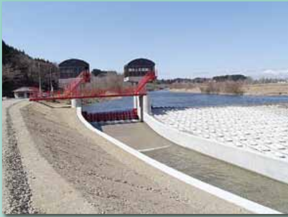
古淵堰頭首工と魚道の整備 こぶちげき 古淵堰地区（十和田市）
