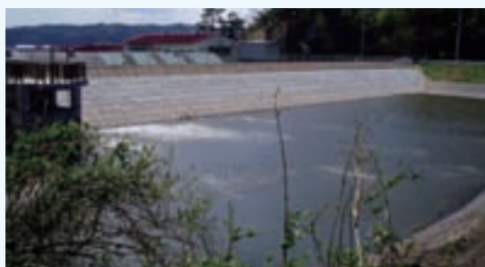
農業用ため池の整備 南部町（旧福地村）待井地区
