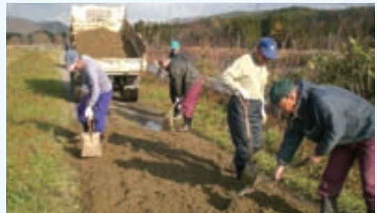
農道の砂利補充作業 むつ市 銀杏木地域資源保全隊
