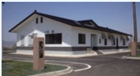
農業集落排水処理場の整備 板柳町・藤崎町 飯田・林崎地区
