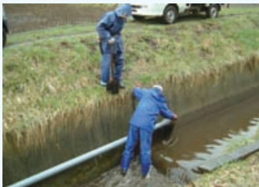
施設の点検 (八戸市 姉市沢保全組合)
