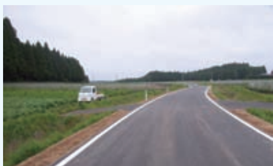
畑地帯に整備された農道 東北町 蓼内地区
