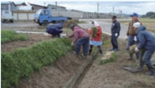
カバープランツ植栽によるきめ細かな雑草対策の実施 外ヶ浜町 下小国水土里保全会
