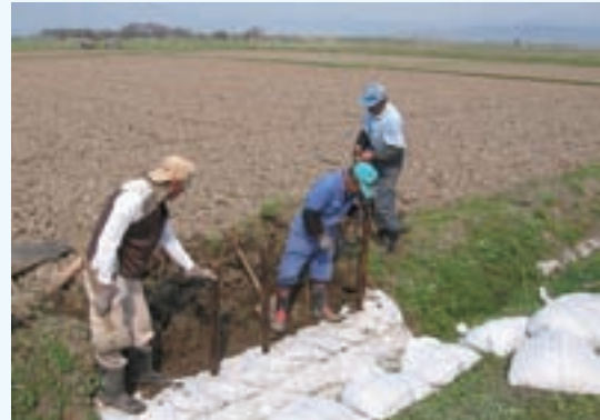
水路法面補修 (平川市 杉館美田保全会)
