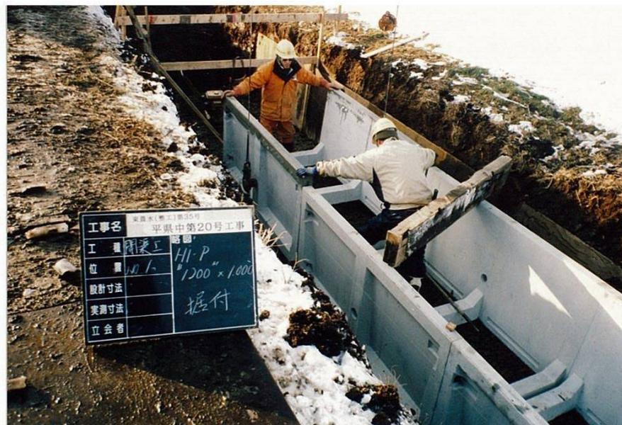
二次製品コンクリート水路(Hi-P水路 B1200×H1000)の据付状況。なお、基礎にはC-40を15cm厚で敷き均している。
