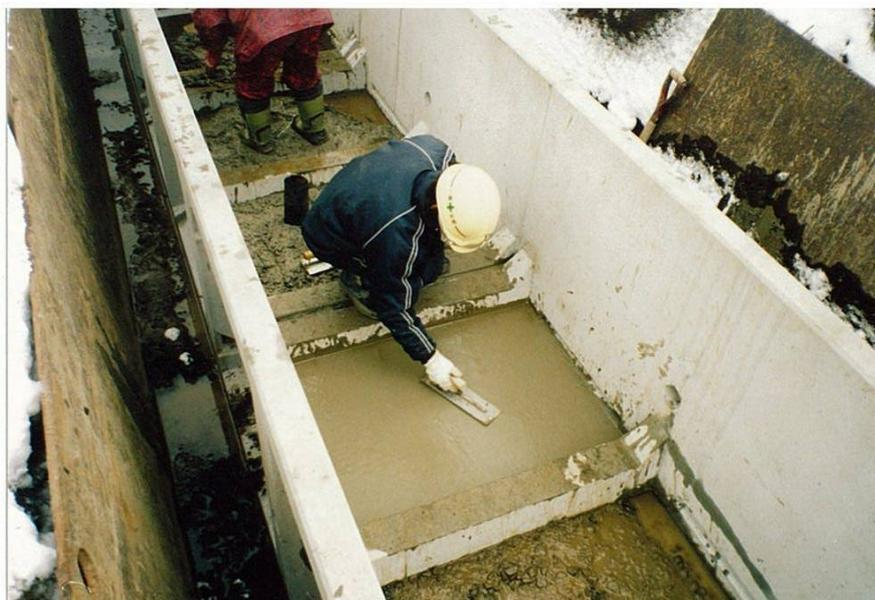
底版コンクリート打設後の、コテ仕上げ状況。厚さ5cm分だけコンクリート打設し、残り10cm分は水路の深みとして確保している。
