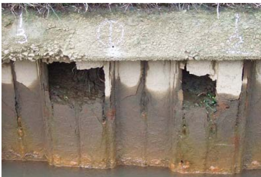
水路の老朽化
