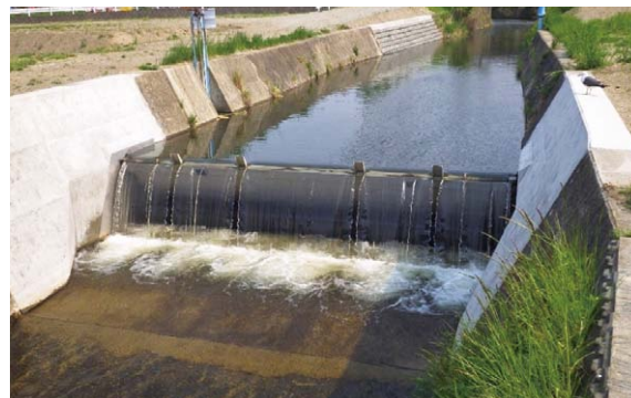
農業用河川工作物応急対策事業 はくさん 白山地区（南部町）
