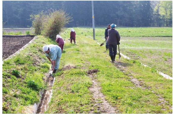
水路の泥上げ
