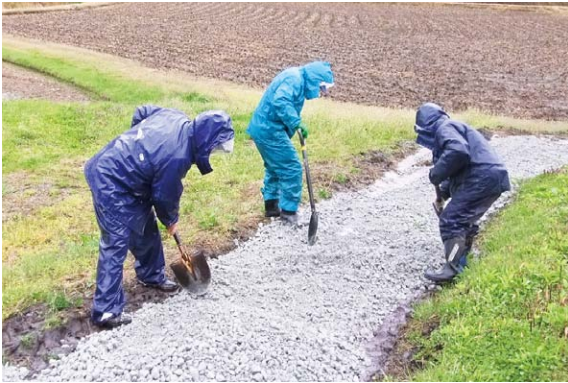
農道の簡易補修
