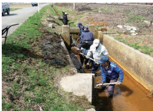
水路の泥上げ
