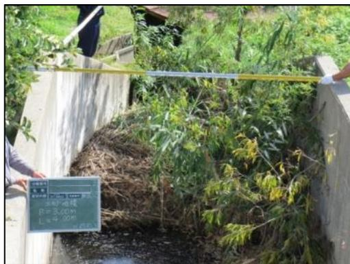
洪水吐部の土砂堆積（通水阻害）の状況
