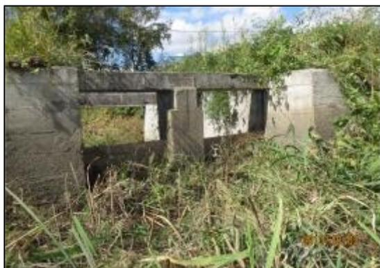
洪水吐に土砂が堆積し植物が繁茂している例
