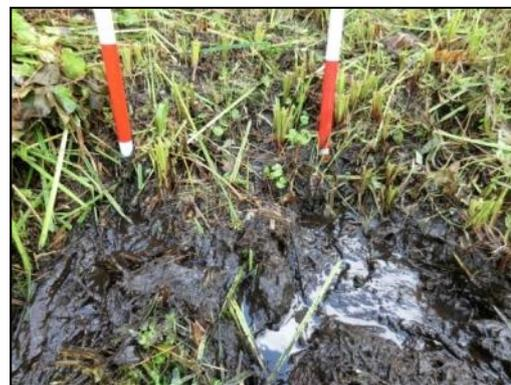
堤体下流法面から漏水している例
