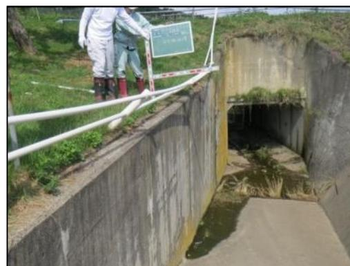
安全柵が破損している例
