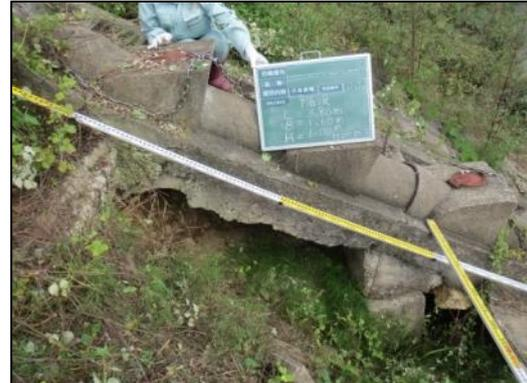
斜樋と堤体の間に隙間が生じている
