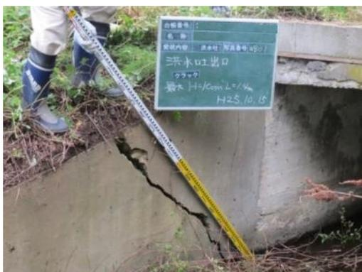
洪水吐側壁ひび割れの例
