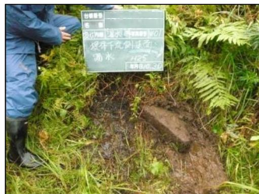
シダ繁茂部から漏水が生じている例
