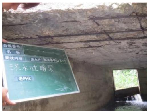
洪水吐部コンクリート鉄筋露出の例
