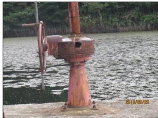
ゲート巻き上げ機の破損事例
