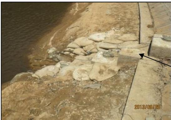
取水施設両脇に開いた隙間に土のうを積み、隙間から堤体へと水が浸透することを防いでいます。
