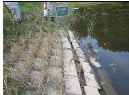
堤体が沈下し護岸ブロックが変形している例
