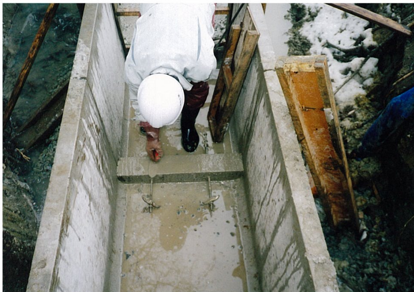
水路 隔壁コンクリート打設状況
