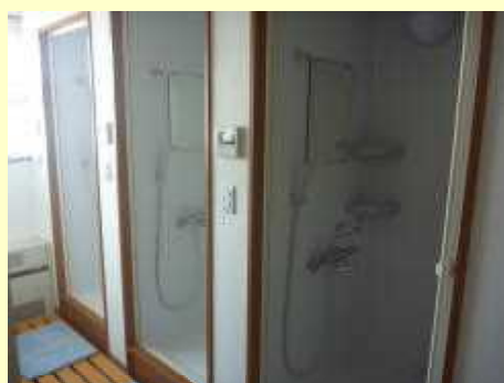
新設された男子寮シャワー室
