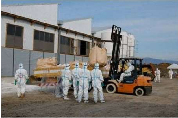
搬出用容器を運搬車両へ積み込み
