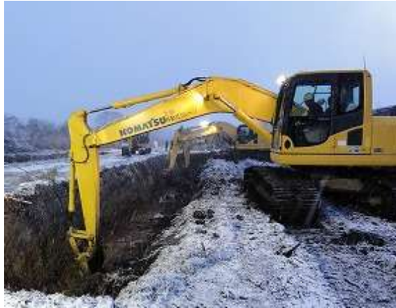
掘削などで使われる油圧ショベル
