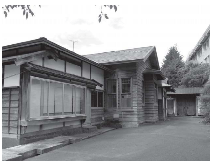
旧津島家新座敷（五所川原市金木町）
