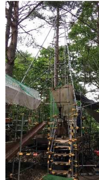
ボーリング調査の様子 (2019年9月)
