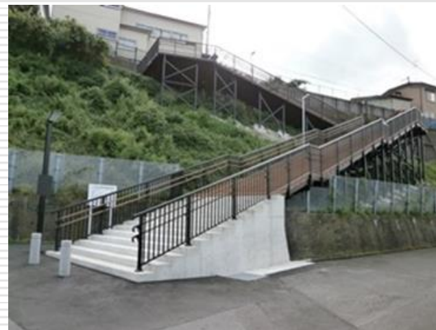
八戸市湊地区の避難階段(4本中1本完成)
