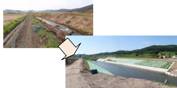
河川改修の例（治水対策）
