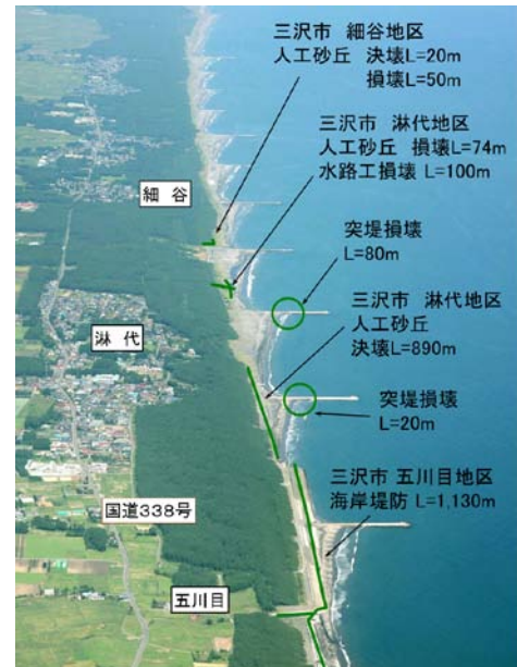
海岸防災林(三沢市)
