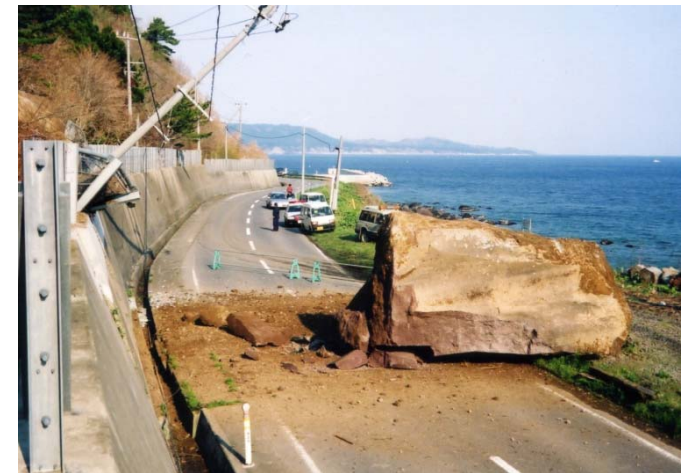
【国道279号落石現場(風間浦村内、H15.5)】
