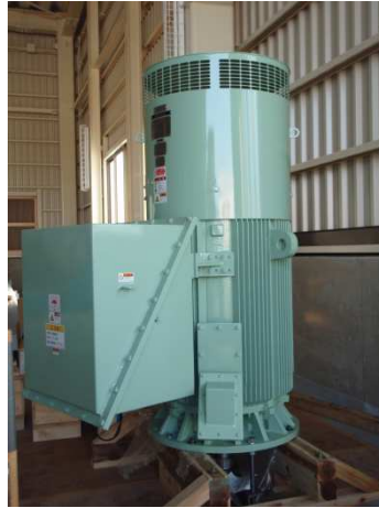
写真2 非常用冷却海水系ポンプモータ予備品の配備状況
