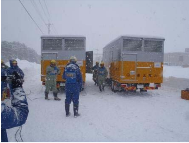
電源車による電源確保訓練
