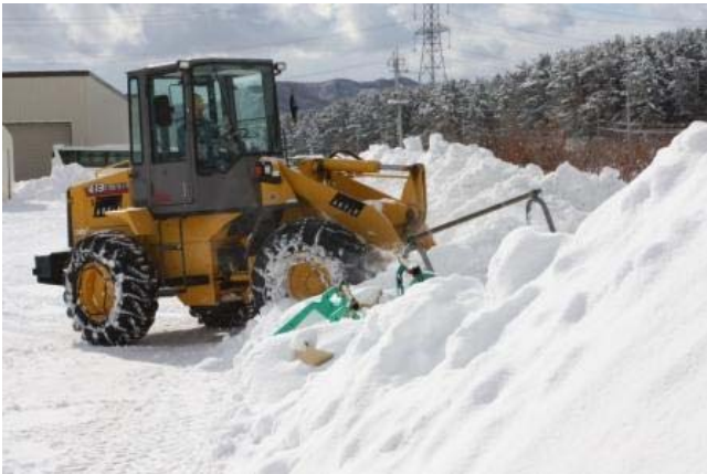
がれき撤去訓練
