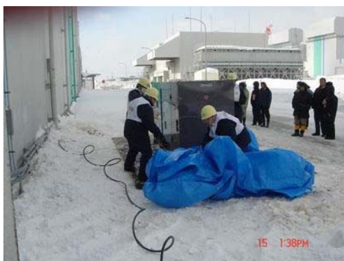
通信設備用発電機による電源供給訓練
