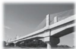
三内丸山遺跡に近い国道7号青森環状道路をまたぐ「三内丸山架道橋」は、橋長450mのエクストラドーズ橋。橋桁を支える橋脚と橋脚の間隔は最大で150mもあり、新幹線の鉄道橋で日本一広い間隔です。
