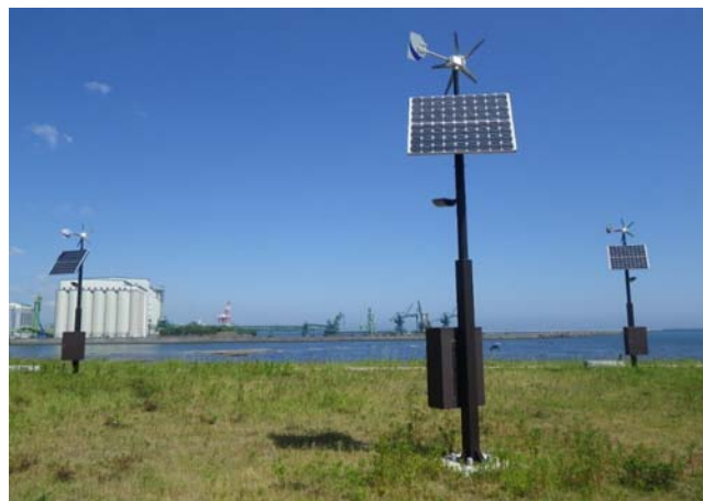
【ハイブリット(太陽光・風力発電による)照明灯】
