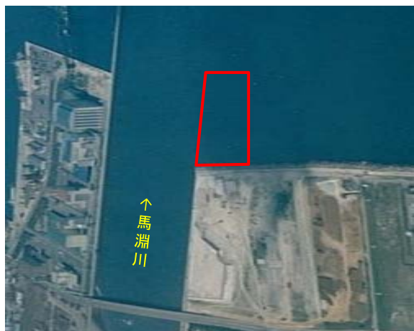
【事業実施前の状況】
