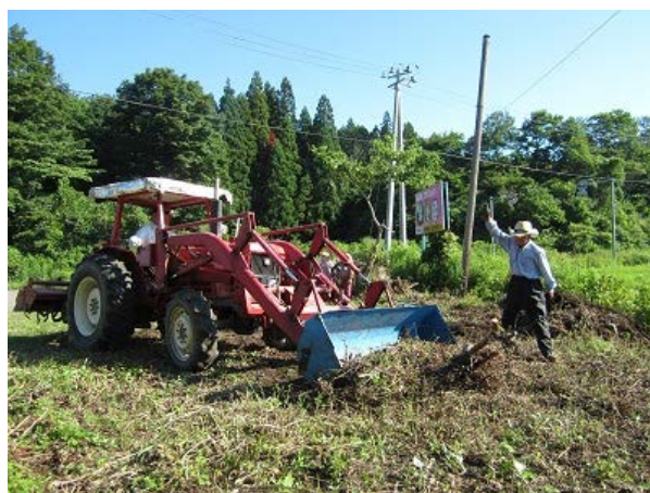
〈住民が自ら重機で整地〉
