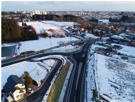
【完成状況写真】
