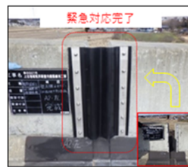
壁高欄遊間カバー復旧 (三本木跨線橋)
