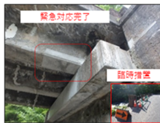
主桁下面の断面修復(通天橋)
