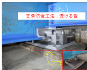
支承の腐食防止対策 (稲生橋側道橋)
