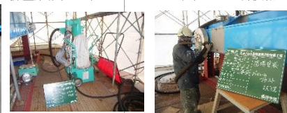
粉塵飛散防止(バキュームプラスタ工法)NETIS 新技術
