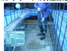
【コンクリートの打継目処理】
