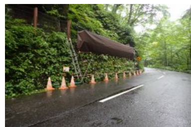
茶系シートによる養生(仮設足場)
