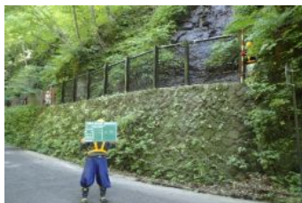
完成(国道102号:落石防護柵)
