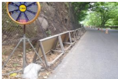
木製バリケードの設置
