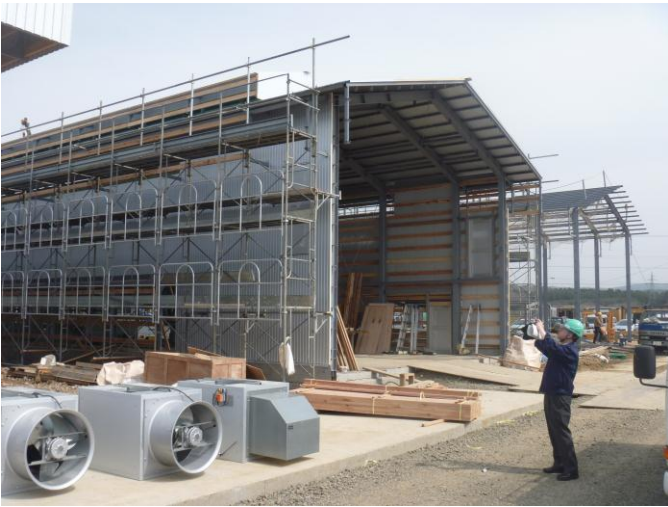
斗南養鶏の鶏舎建築現場
