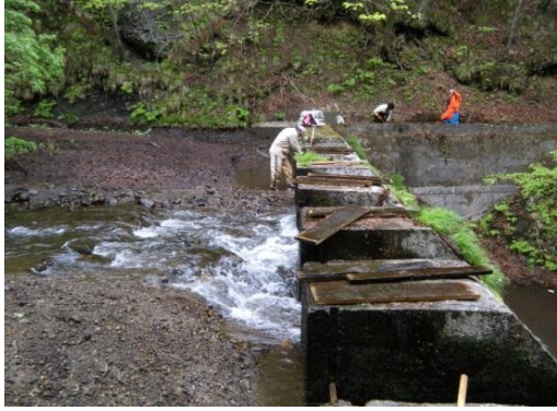
取水堰の維持管理作業（風間浦村）
