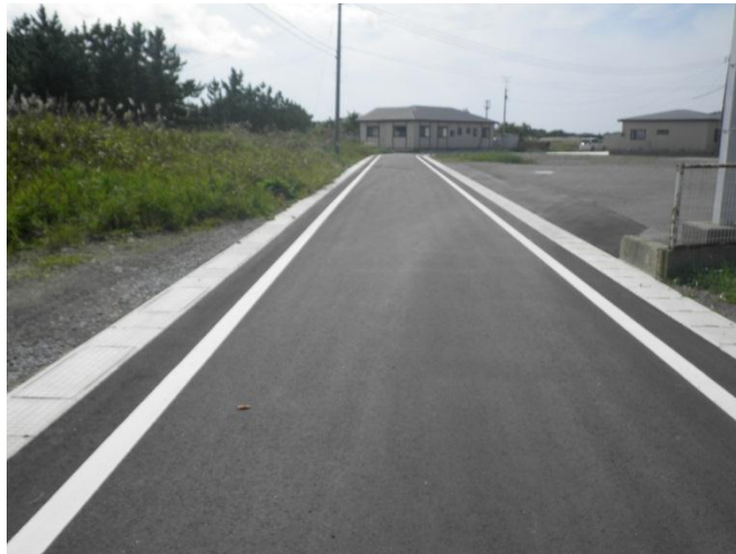
整備後の農業集落道（大間町下北北部地区）
