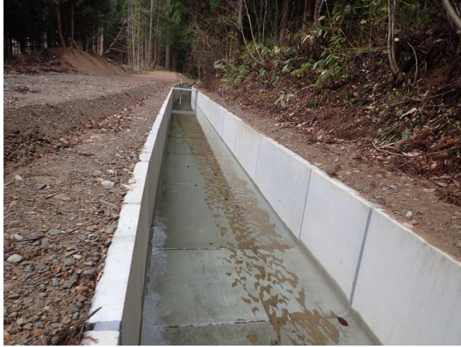
整備後の用水路（むつ市川内地区）
