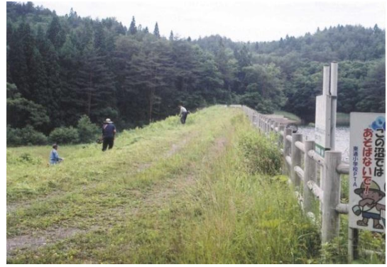
ため池堤体の草刈作業（東通村）
