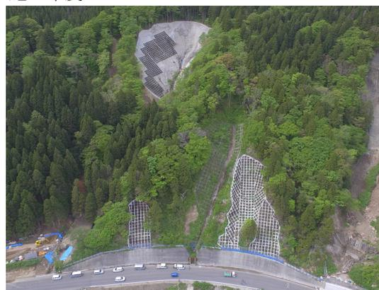
豪雨で崩壊した山腹斜面の安定を図るため、簡易吹付法砕工を実施。
