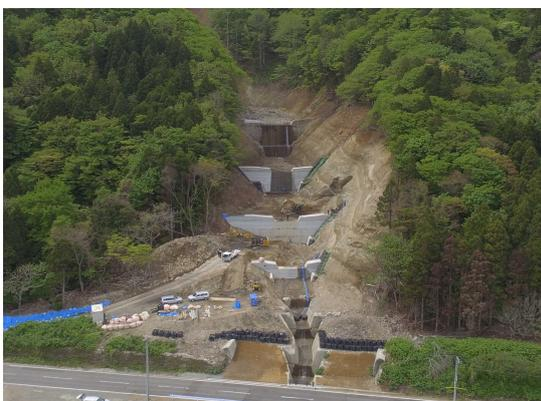
溪流の侵食を防止し溪床の安定、山脚の固定及び土砂の流出の抑止・調整を図るため治山ダムを設置。
