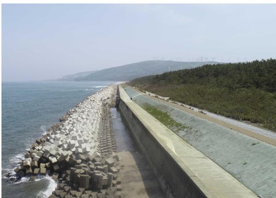
防潮護岸工基礎部を波浪による洗掘から保護するため、コンクリートブロックを設置。
