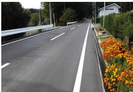
通作条件整備事業 階上道仏地区(階上町、R3～R7) 基幹農道の路面改良
