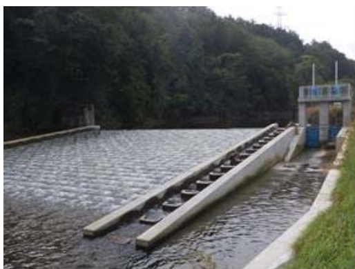
生態系に配慮した魚道整備 上川原地区（三戸町）
