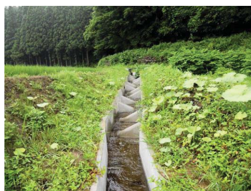
環境に配慮した魚道型水路の整備 十和田西部地区（十和田市）
