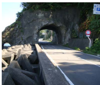
国道339号線に残る親子洞門
