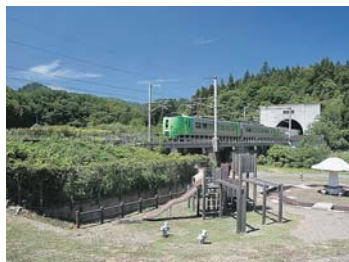
青函トンネル入口
