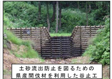
土砂流出防止を図るための
