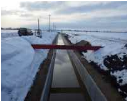
基幹水利施設ストックマネジメント事業 川倉地区（青森市、H25～H29）
