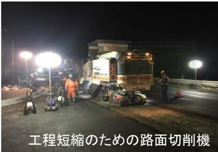
工程短縮のための路面切削機
