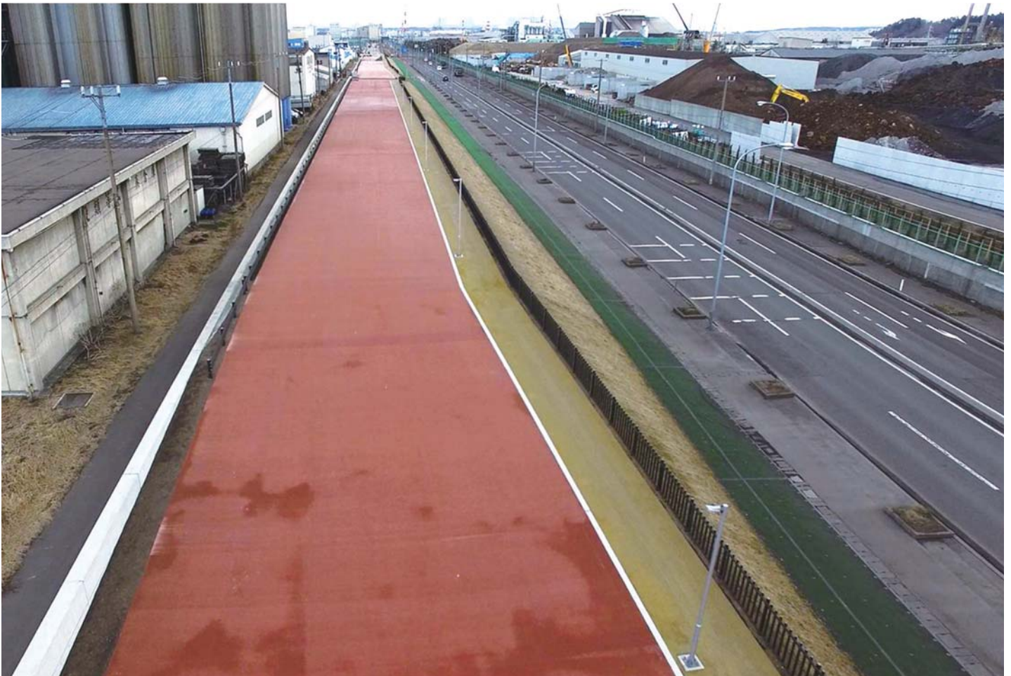
八戸港 防潮堤
