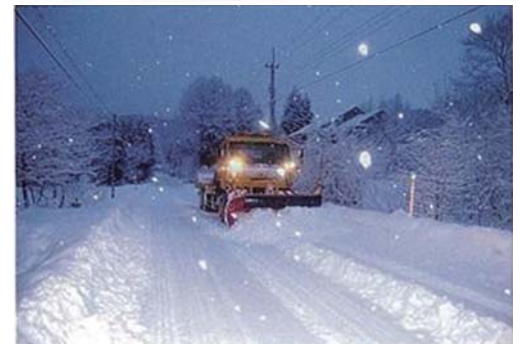
新雪除雪作業中
