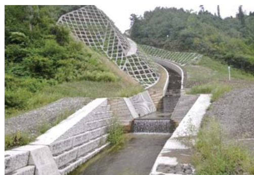
遠瀬沢溪流保全工(H24年完成)
