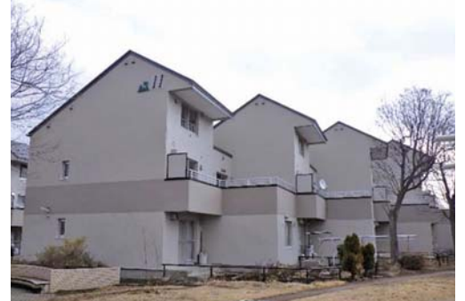
県営住宅旭ヶ丘団地 (平成29年度改修工事完成)
