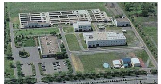
馬淵川浄化センター (愛称:馬淵川きらきらセンター)
