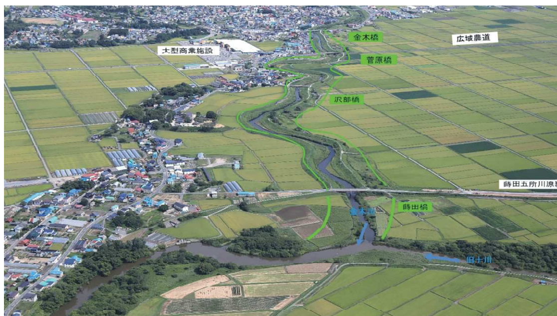
金木川大規模特定河川事業及び旧十川広域河川改修事業（五所川原市）
