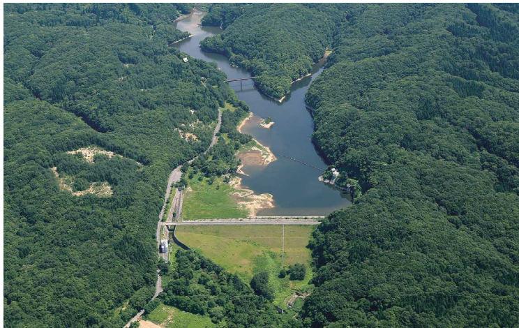
飯詰ダム (五所川原市)
