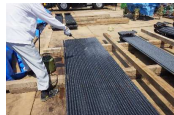
鉄筋の防錆処理
