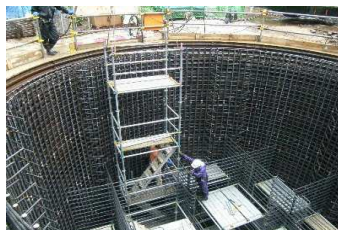
大口径深礎工
